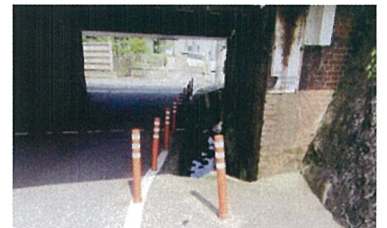
側溝(ガード下)
