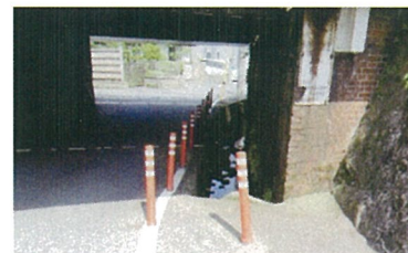
側溝(ガード下)
